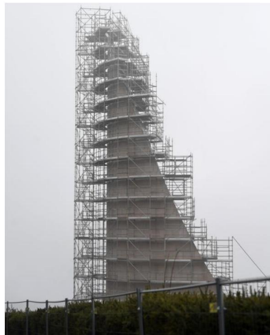
La flamme de béton munie d'un parement de pierre a été garnie d'un échafaudage d'une quarantaine de mètres de hauteur. PHOTO DNA - JSA
